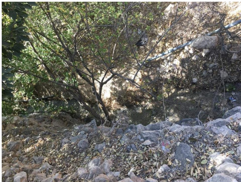
شکل ۱- رویش درختان در بدنه سنگی کانال
